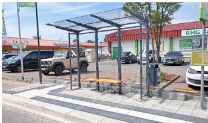
Barrierefreie Bushaltestelle am Parkplatz Baumarkt RHG mit Fahrgastunterstand im Gewerbegebiet „Goldbach“ mit Förder-
