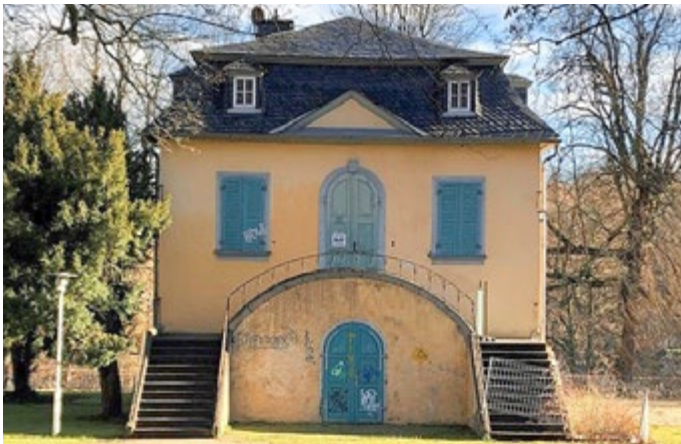
Instandsetzung der maroden Freitreppe des Parkpavillons
