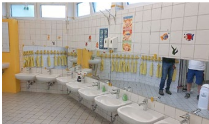
Im Kindergarten „Kinderland“ wurde ein Waschraum teilsaniert und die Außendusche mit Fördermitteln des Landes Thüringen instandgesetzt.
