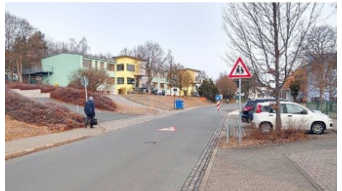
Neubau eines Fußgängerweges in der Karl-Marx-Straße im Bereich der Freien Montessori-Gemeinschaftsschule
