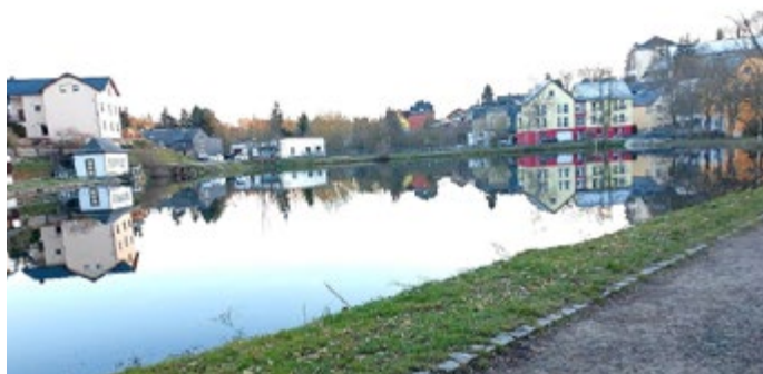
Stadtteich: Sanierung des Grundablasses und der Wehrschwelle am Zulauf mit Fördermitteln des Landes Thüringen im Förderprogramm „Klima Invest“
