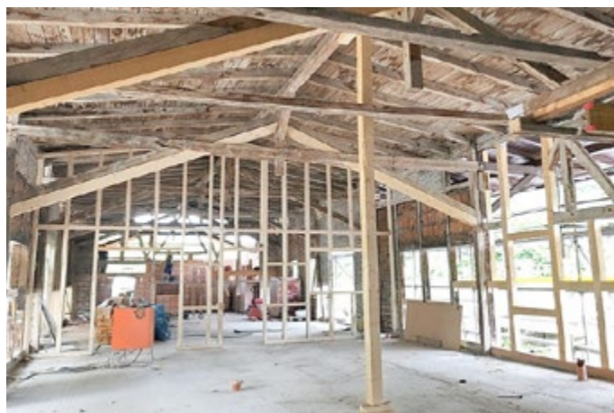
Fortführung der energetischen Sanierung des Bahnhofsgebäudes in Bad Lobenstein
